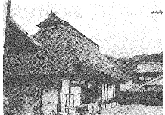
写真7 旧太田家住宅 寄棟造り，箱棟 城川町古市 （現在 城川町歴史民俗博物館）
