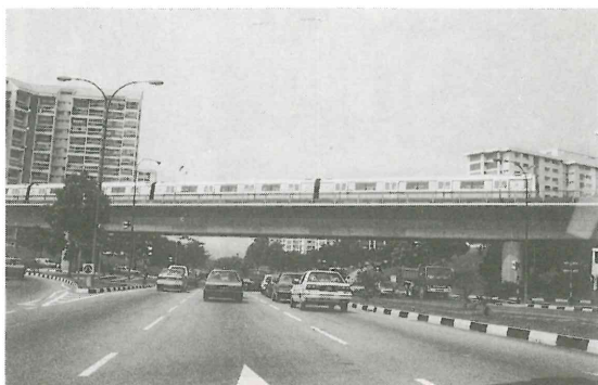
郊外に出ると、地下鉄（マストランジット、MRT）は高架に変わる（MRT西線、コモンウェルス自動車道にて）
