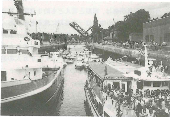
写真3 チッテンデン水門（大）で繋留中の船舶、上流のワシントン湖側へ移動中。背後（下流側）には開閉橋が遠望できる
